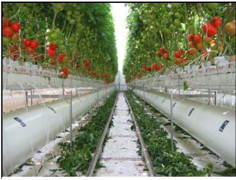
Gaines de distribution d'air chaud et froid
